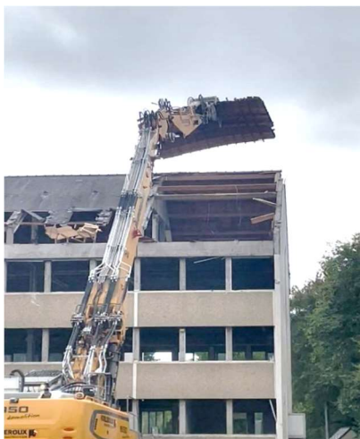
Dépose de la couverture suivie d'une séparation bois, ardoises. Grue Liebherr 960
