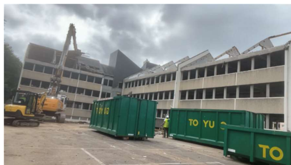
Benne de tri déchets recyclables. 7000 tonnes de béton pour 7000 m 2 de surfaces de plancher.
